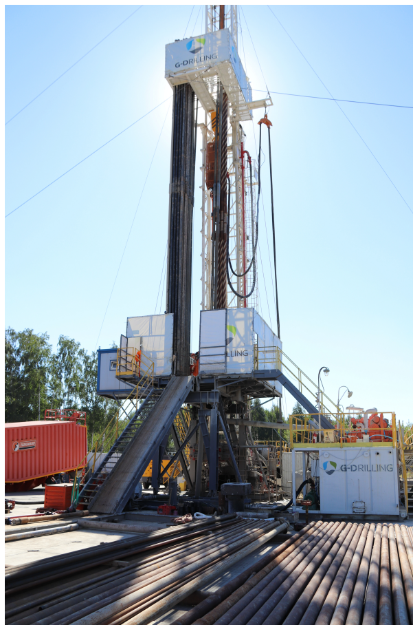
Fot. Odwiert geotermalny przy ul. Zachodniej.
