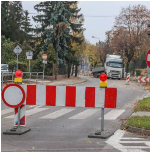
Przebudowa kanału deszczowego w ul. Toruńskiej – 1.727.068,26 zł
