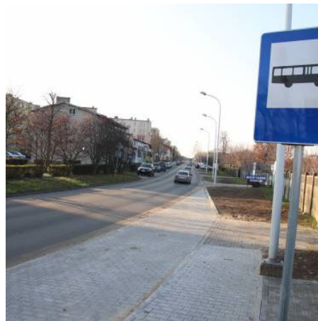
Budowa zatok autobusowych i zjazdów – 196.343,85 zł
