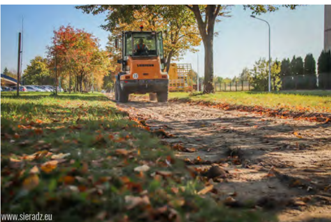
Budowa chodnika na ul. 3 Maja
