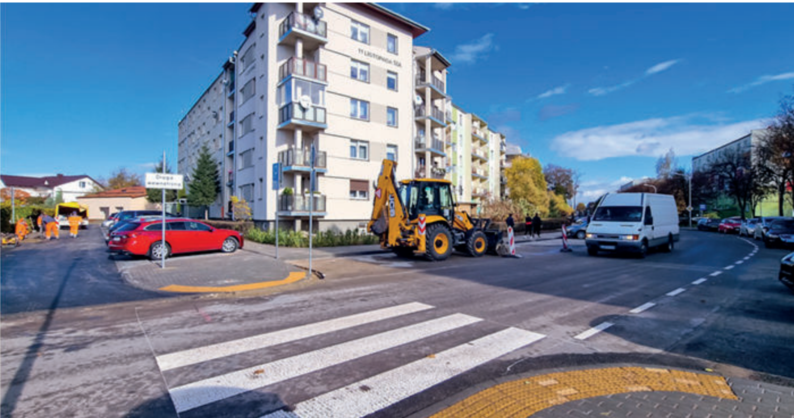
Przebudowa chodników i parkingów przy ul. 11 Listopada
