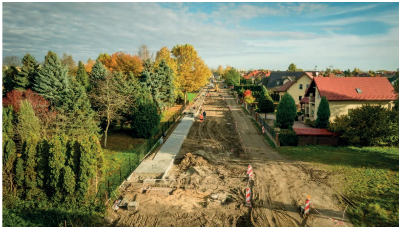
Budowa ulicy Różanej wraz z przebudową ulicy Tulipanowej
