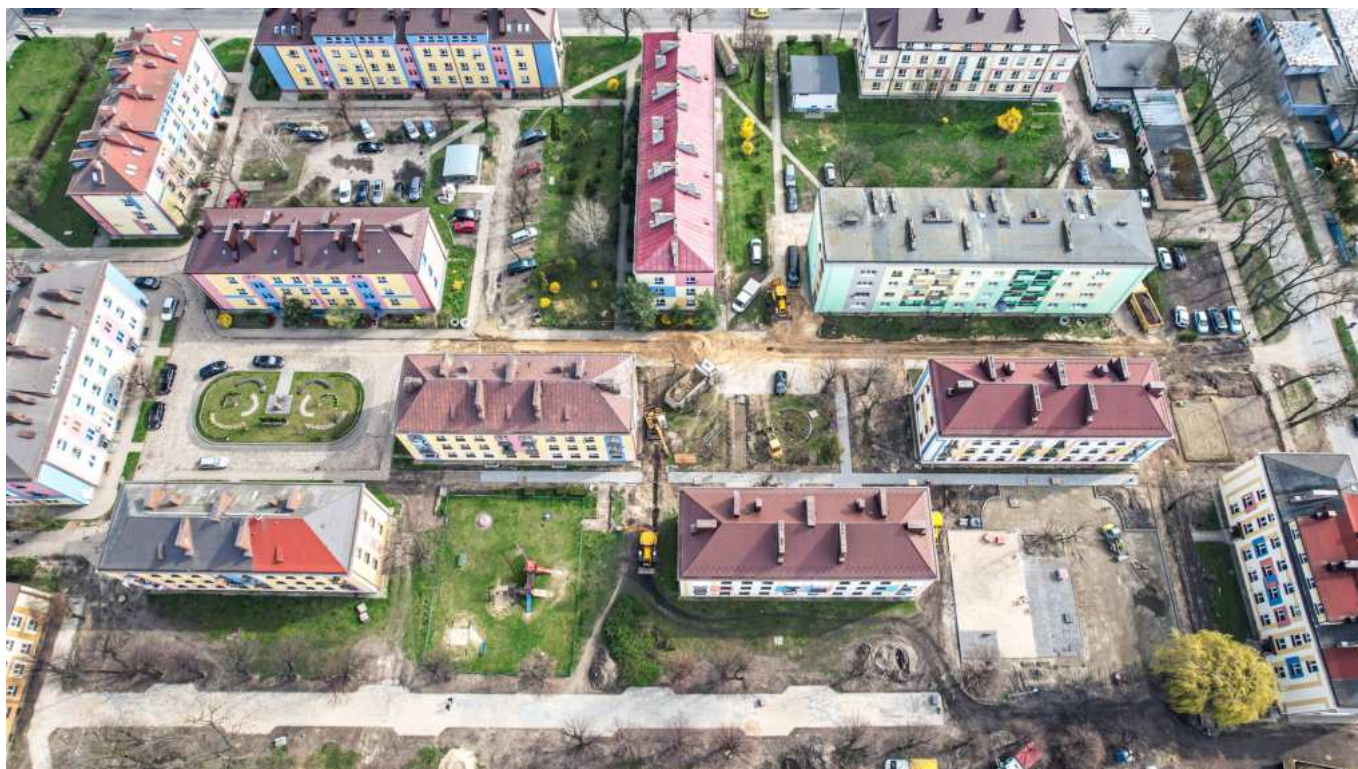
Przebudowa dróg wewnętrznych i parkingów przy ul. Powstańców Warszawy
